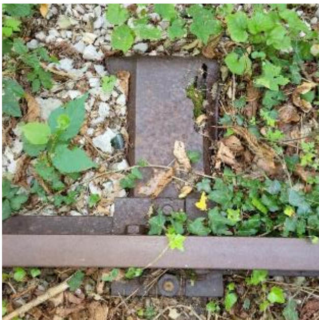
Eclisse intermédiaire fixée à une traverse perforée
