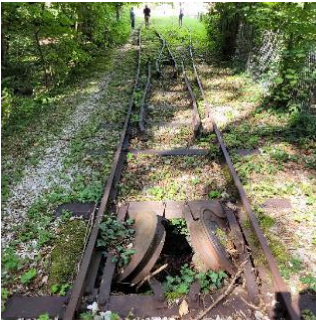
Vue depuis l'amont de l'évitement
