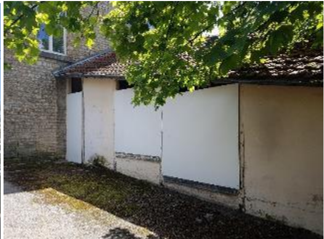
portes et fenêtre condamnés
