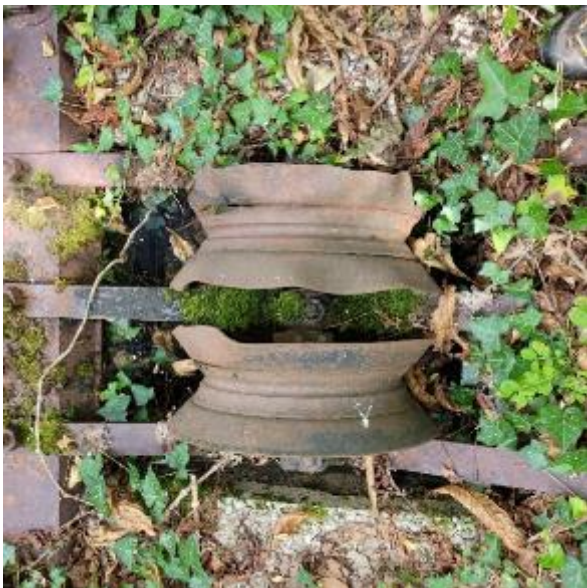
Galets de ligne déformés
