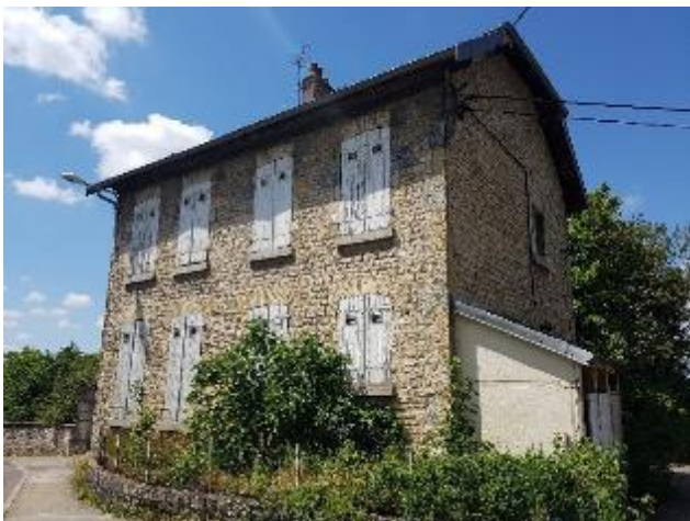
Bâtiment accueillant la machinerie au sous-sol
