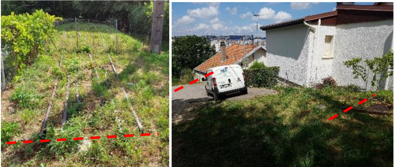
Section de voie supprimée au passage de la route
