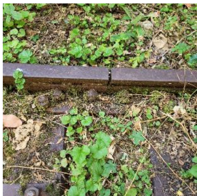
joint de rail éclissé
