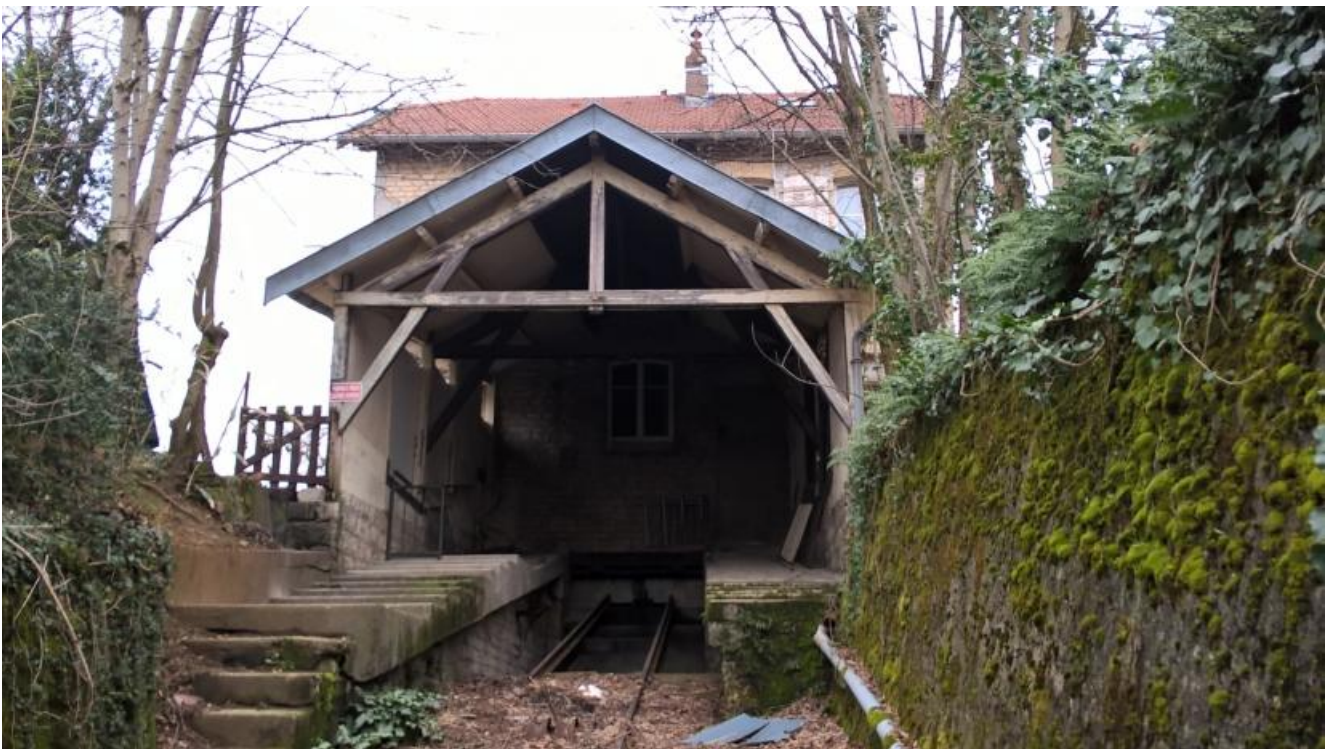
La gare haute, côté voie, en 2016
